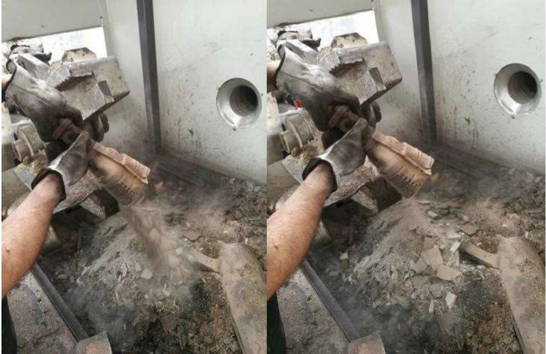
图 4.1-2 清空催化器操作照片（参考照片）
